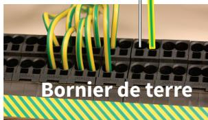
Si l'installation est biocompatible et donc câblée en Flex-A-Ray, **il faut absolument raccorder une des deux extrémités du drain de terre de chaque section de tube à la terre.** Au départ du circuit, le drain est raccordé sur le bornier de terre du coffret, l'autre extrémité du drain ne sera pas raccordée et sera isolée et repoussée dans le fond du boîtier.
